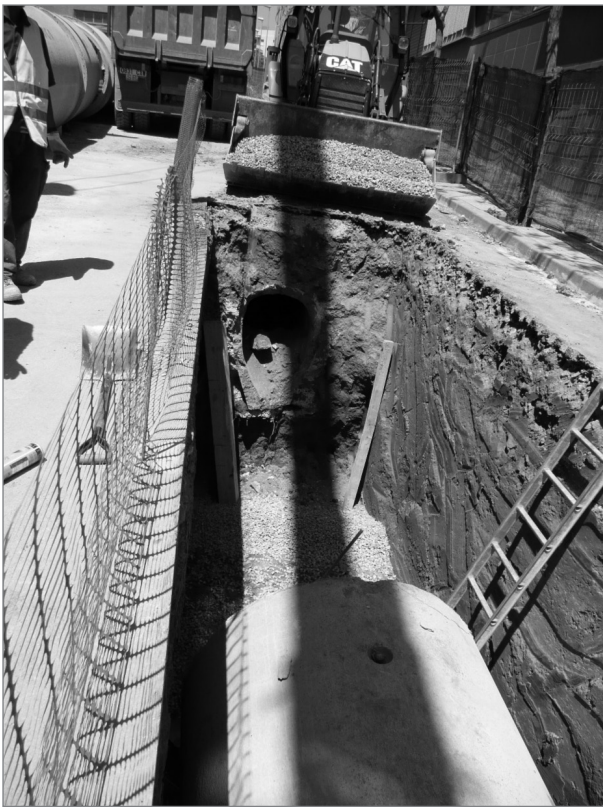
Foto 2. Ejecución de la obra de saneamiento del proyecto A. Fuente: MIMAMB (2009).
