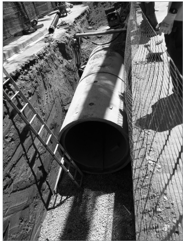
Foto 3. Ejecución de la obra de saneamiento del proyecto A. Fuente: MIMAMB (2009).
