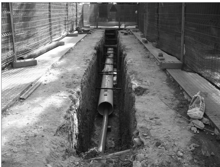
Foto 1. Ejecución de la obra de saneamiento del proyecto A. Fuente: MMAMB (2009).
